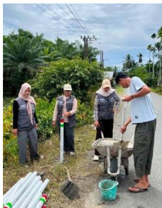
Gambar 1. Pemasangan Reflektor Jalan
