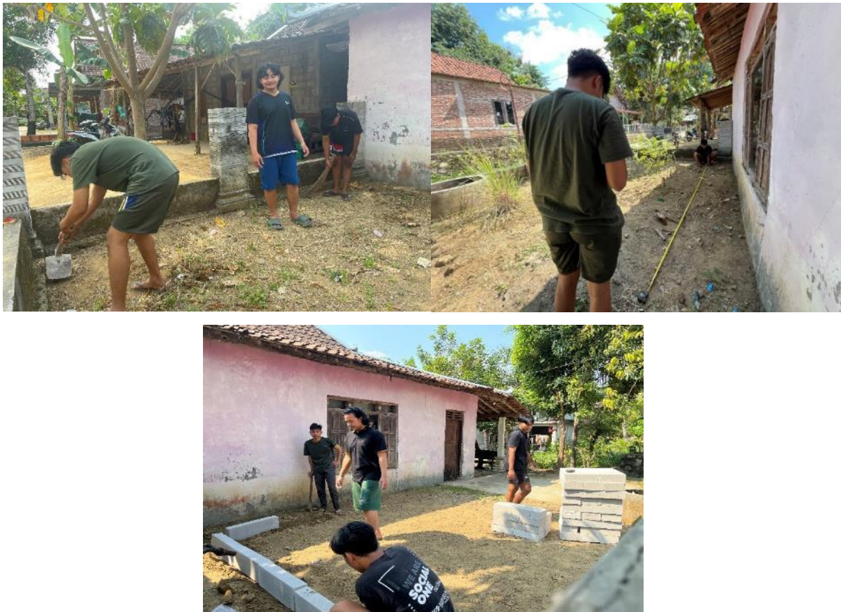
Gambar 5, 6 dan 7. Proses pembersihan, Pengukuran lahan, dan Penyusunan bata ringan membentuk raised bed , (Sumber: Dokumen Pribadi, 2026).
